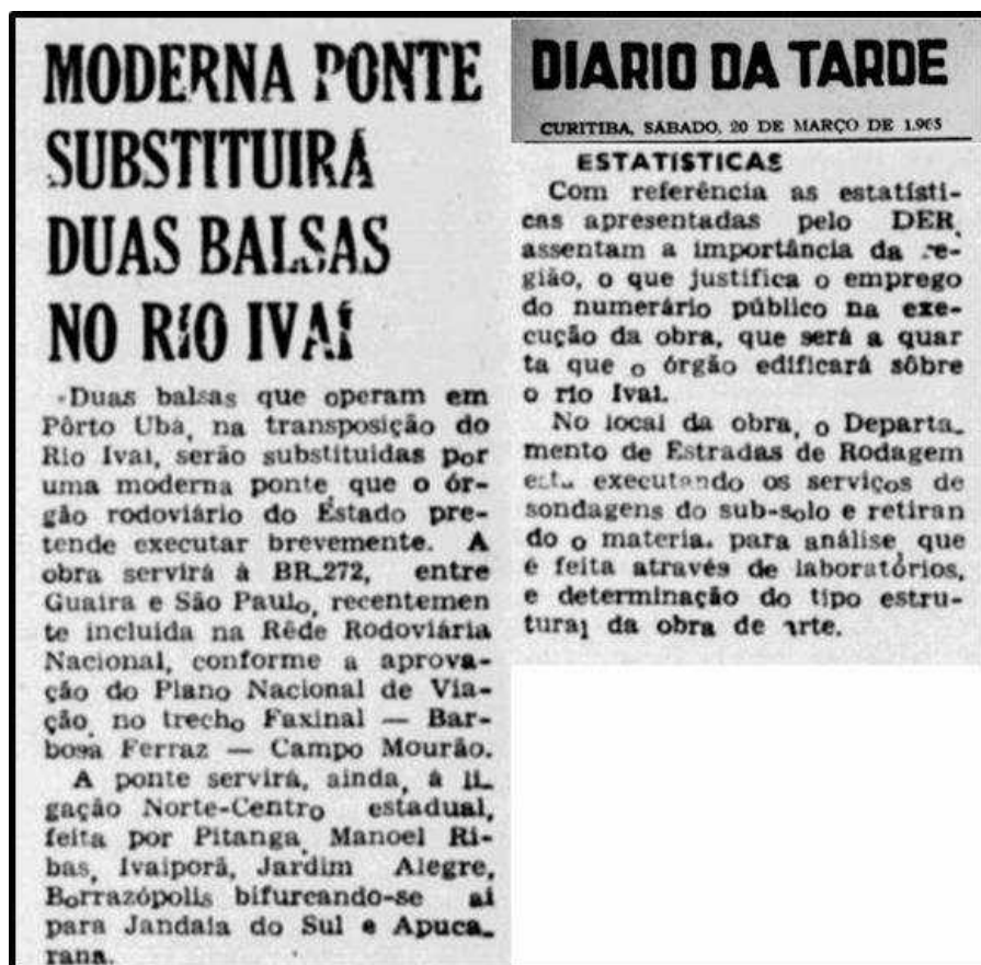
Figura 12 – Notícias sobre a construção da ponte no rio Ivaí - Porto Ubá (1965)
